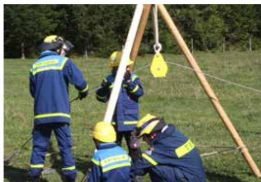
Aufbau des Dreibockes für eine Seilbahn
